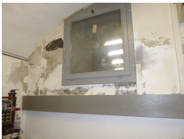
Dégradation mollasse façade Sud
