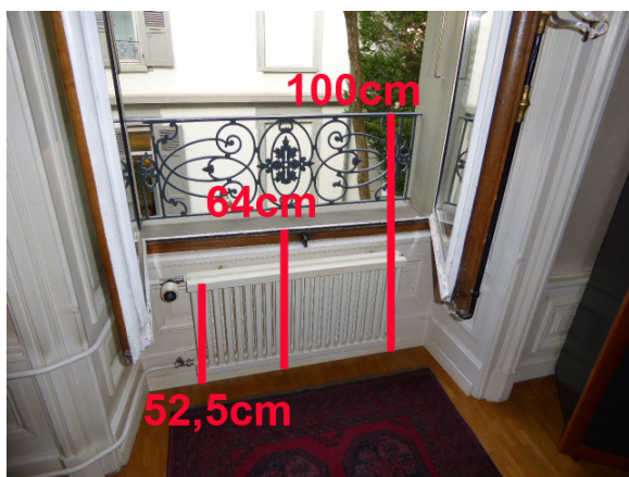
Balustrade escalier non conforme
