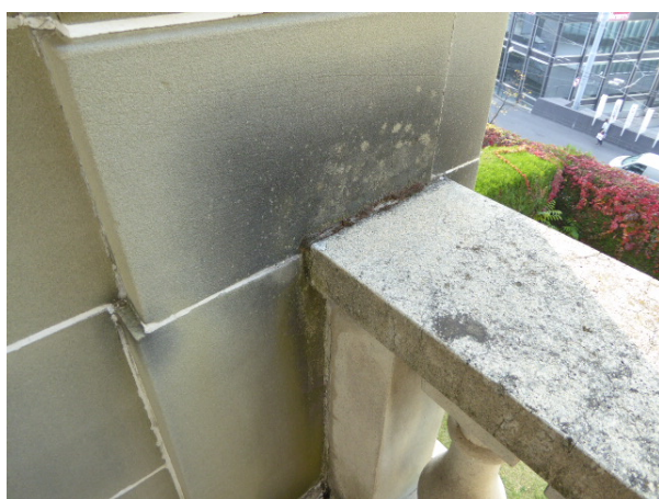
Dégradation mollasse façade Sud
