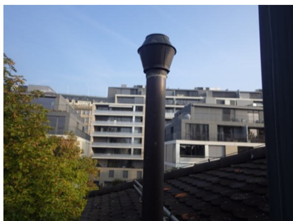
Capuchon de toiture mal positionné
