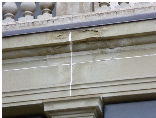
Dégradation mollasse façade Sud
