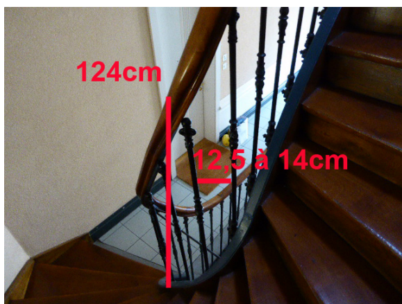
Balustrade escalier non conforme
