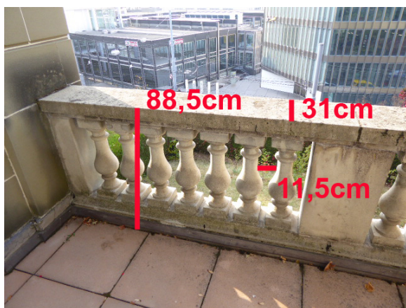
Contrecœur fenêtre non conforme
