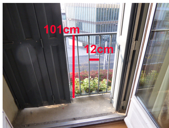
Contrecœur fenêtre comble non conforme
